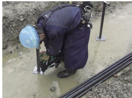
梁受架台留め 作業イメージ
